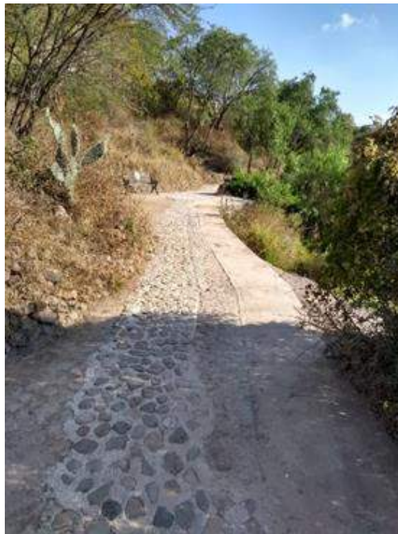
Red de alcantarillado sanitario en la zona de la Presa de los Santos con colector sanitario tubería de PVC serie 20, descargas domiciliarias, registros sanitarios, pozos de visita tipo común.
