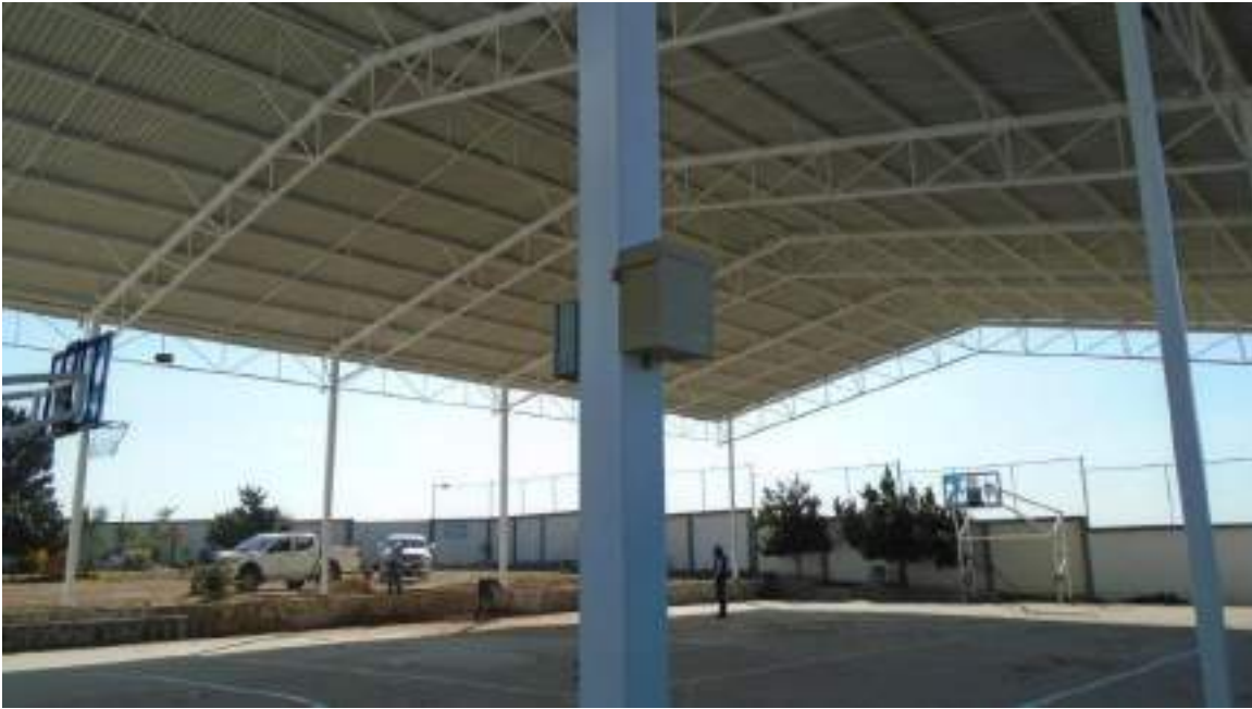
Techado de cancha deportiva en el Bachillerato SABES Santa Teresa con estructura metálica y lámina PINTRO.
