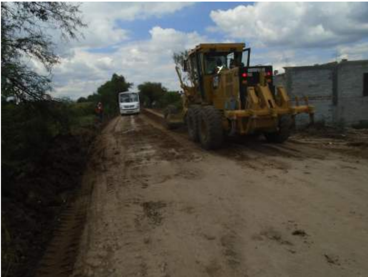
Obra en proceso de rehabilitación de camino en la Comunidad Hacienda de Guadalupe.
