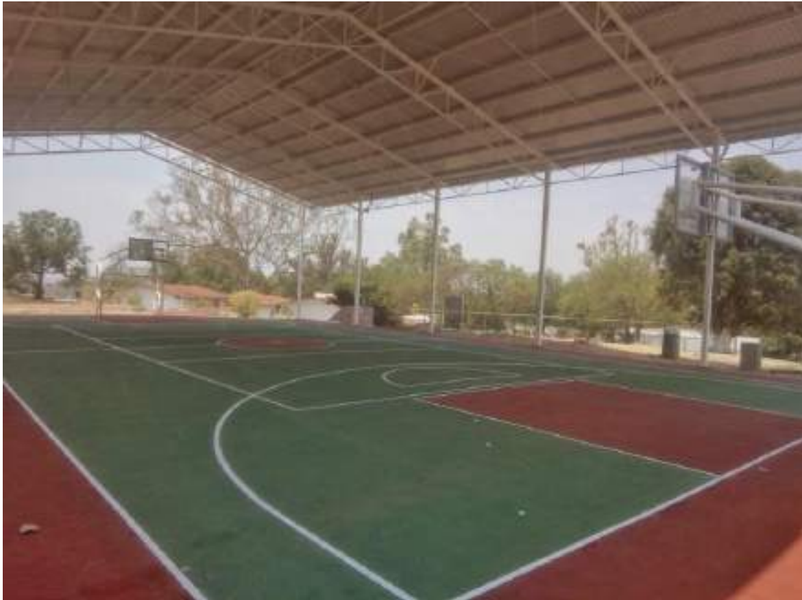
Techado de cancha deportiva en Esc. Prim. Vicente Guerrero con estructura metálica y lámina PINTRO.
