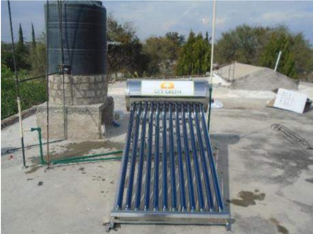
Calentador solar totalmente instalado y en operación.
