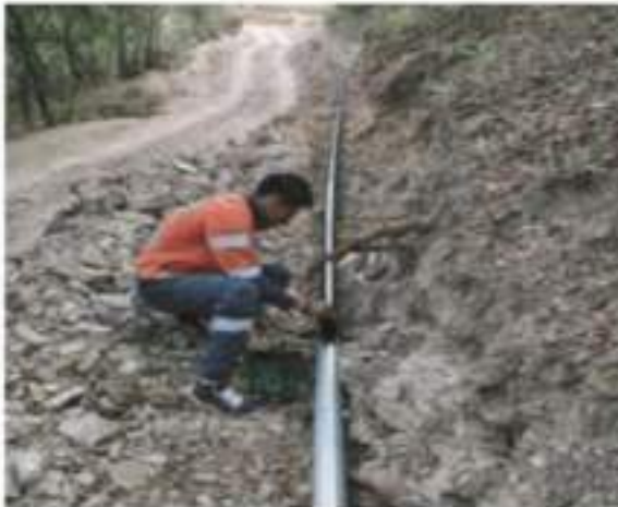
Rehabilitación de línea de distribución de agua potable, tramo km 0+000 al km 0+2342, en la comunidad de Monte de San Nicolás, en el Municipio de Guanajuato. (Instalación de tubería de fierro galvanizado).
