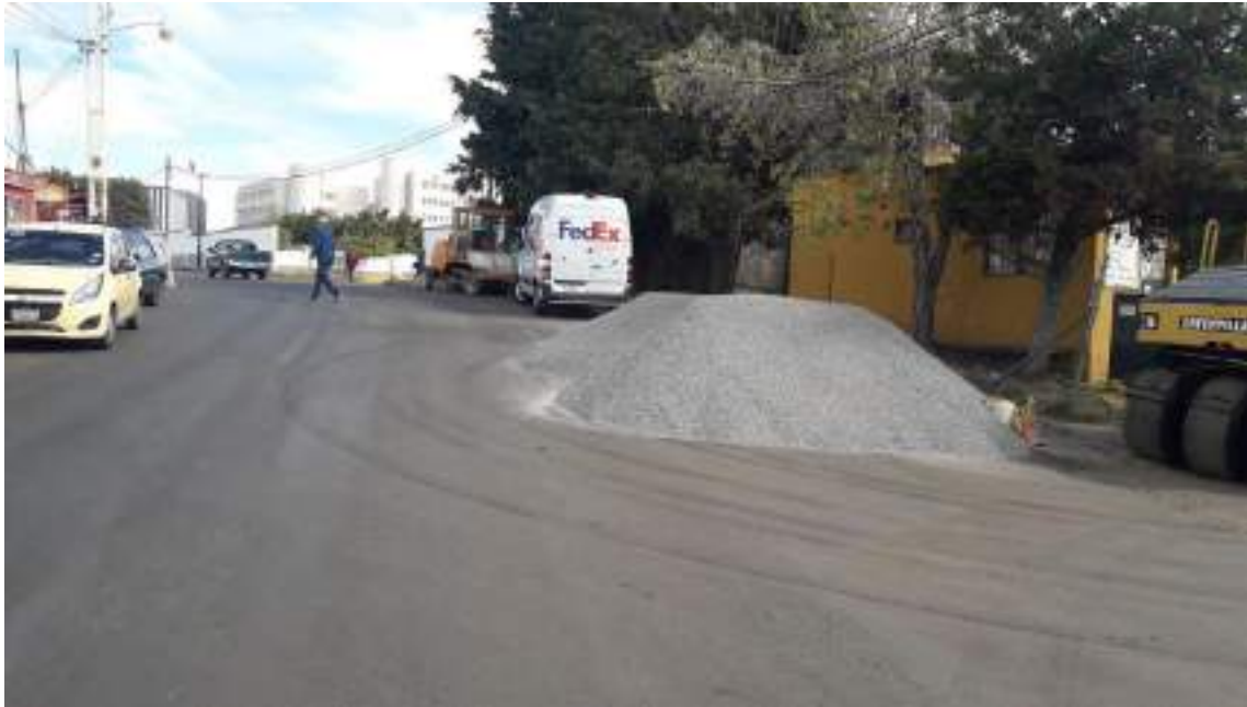
Bacheo en Camino a Cata, pasando el Instituto Ignacio Montes de Oca. Previo a colocación de riego de sello en calle Antonio Loma Amézquita, Col. Burócrata, en el tramo de acceso a Central de Autobuses hasta el Hospital General.
