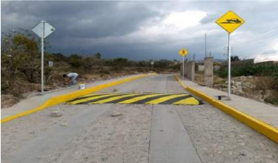
Obra terminada calle principal de Carbonera 2 da etapa.
