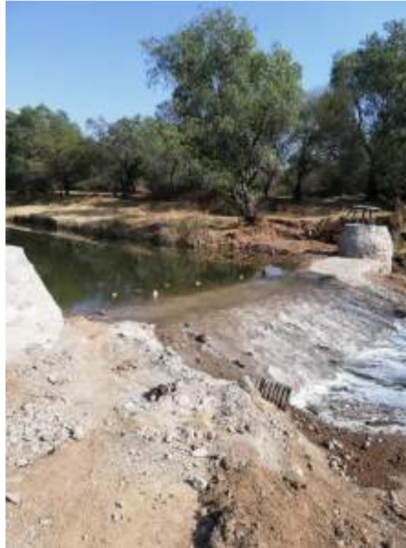
Cruce de río protegido con mampostería de piedra braza y pozos de visita cabeceros en colector sanitario Río Guanajuato.
