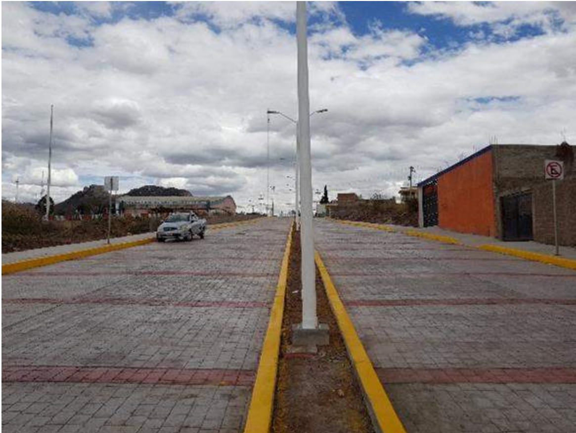
Calafateo de cortes en pavimento de concreto hidráulico en calle la Biznaga.
