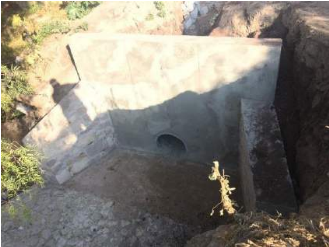
Obra de descarga en la interconexión con el Arroyo del Arco del colector pluvial de la calle Yerbabuena.
