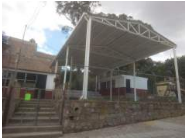
Techado de patio cívico en la Escuela Primaria Emiliano Zapata, Puerto de Santa Rosa.
