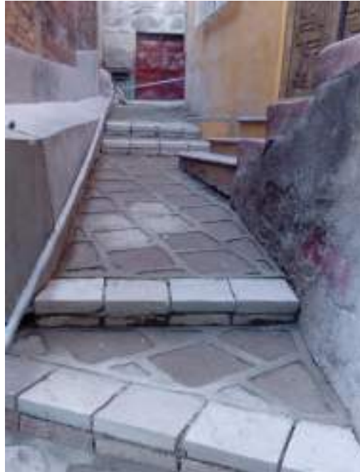
Rehabilitación de instalaciones existentes en callejones de Pardo, Las Flores y Animas.
