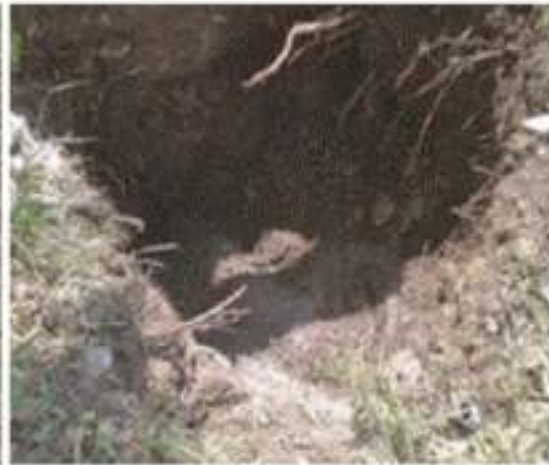
Rehabilitación de la red de bombeo de planta potabilizadora, de filtros a tanque Borrego para el abastecimiento de agua potable en las comunidades de Mineral de Santa Ana y Llanos de Sta. Ana, en el Municipio de Guanajuato. (Excavación para colocar equipo de bombeo).
