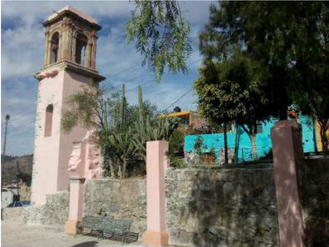
Retiro de maleza, sustitución de piezas dañadas, aplanados y pintura a la cal en Torre Campanario Gildarda en Mineral de Mellado.
