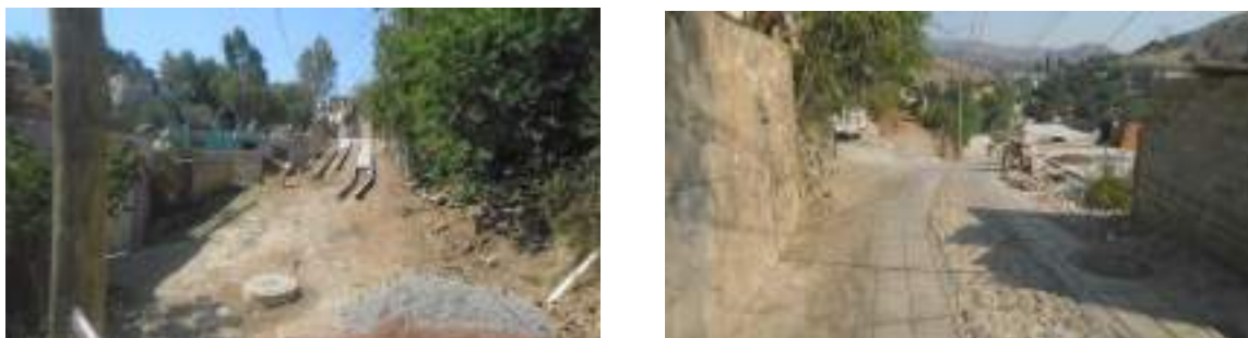
Comunidad Mineral de Santa Ana, Pavimentación de Calle Trinchera.
