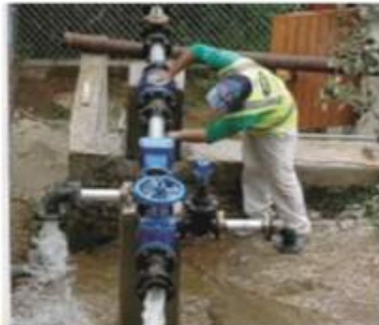
Rehabilitación del equipo de bombeo y planta potabilizadora en comunidad Mineral de la Luz, en el Municipio de Guanajuato. (Arreglo de tren de válvulas y puesto en operación para prueba).
