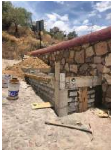
Subida Deportiva Torres Landa Colocación de mobiliario urbano
