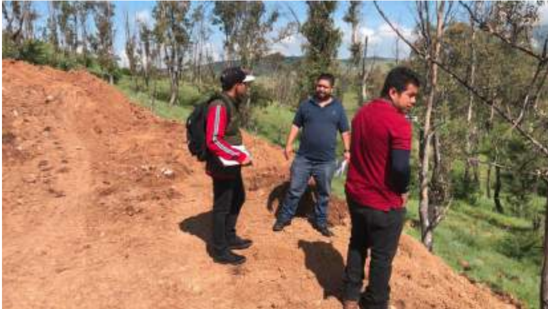
Inspectores de la DGMAOT levantando acta por trabajos de excavación en zona de preservación agrícola en Santa Teresa.
