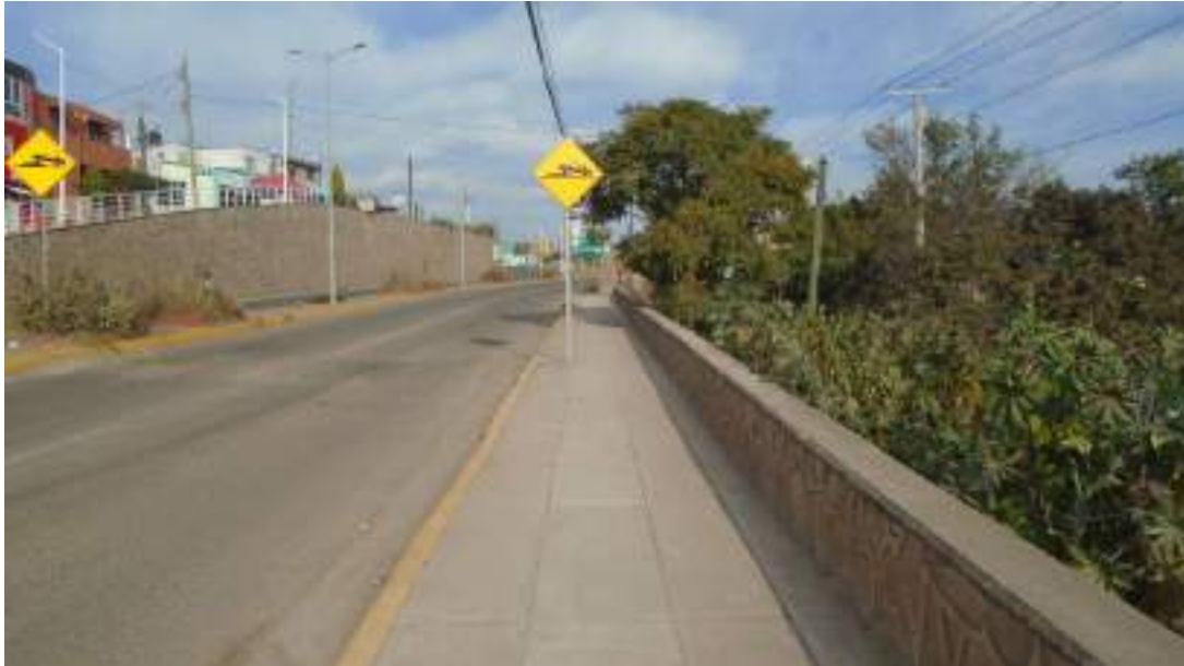
Rehabilitación de la línea de conducción de agua potable en cárcamo Yerbabuena al Tanque 3 Estrellas.
