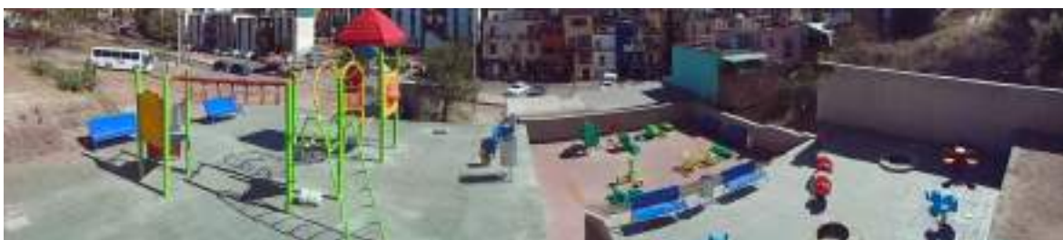
Construcción de plaza pública en Colonia Las Teresas, equipada con mobiliario urbano, ejercitadores, juegos infantiles y plantación de árboles y pasto.
