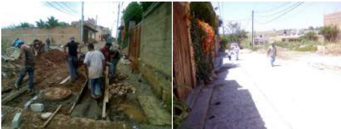
Comunidad Santa Teresa, Pavimentación de Calle Salamanca
