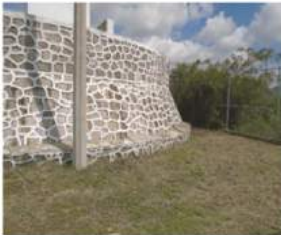
Rehabilitación de tanque Borrego para el abastecimiento de agua potable a las Comunidades de Mineral de Santa Ana y Llanos de Sta Ana, en el Municipio de Guanajuato. (Excavaciones para colocación de equipo de bombeo).
