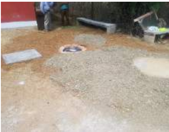
Construcción de sistema de tratamiento de agua residual mediante biodigestor y pozo de absorción en la comunidad de Mexiamora, en el Municipio de Guanajuato. (Obra terminada).
