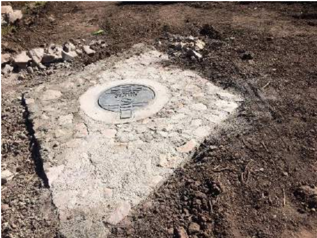
Obra terminada de la ampliación del colector sanitario Arroyo Verde, se observa diamante para protección de pozo de visita.
