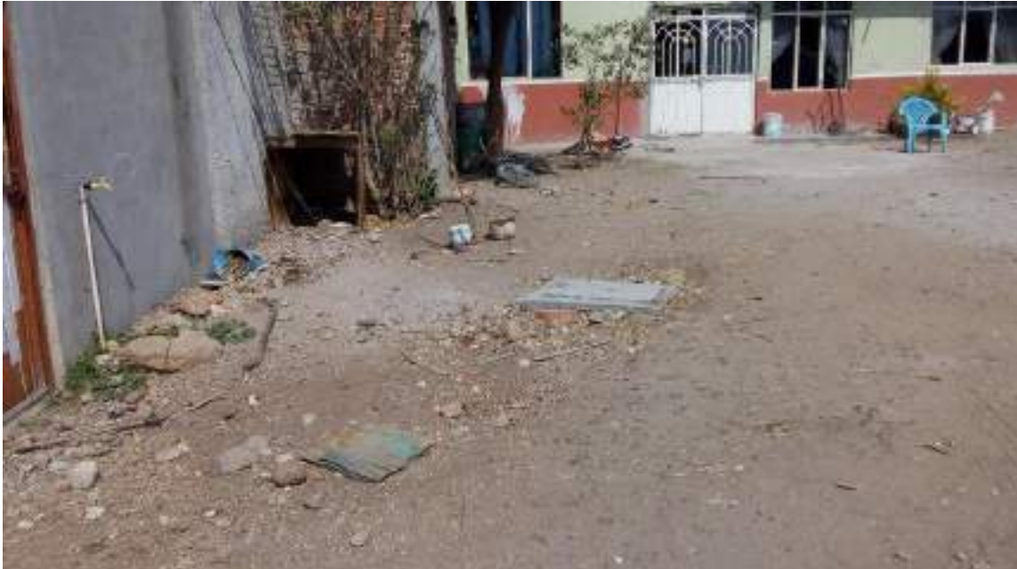
La red de distribución de agua potable en San José de Llanos 4ta. etapa.
