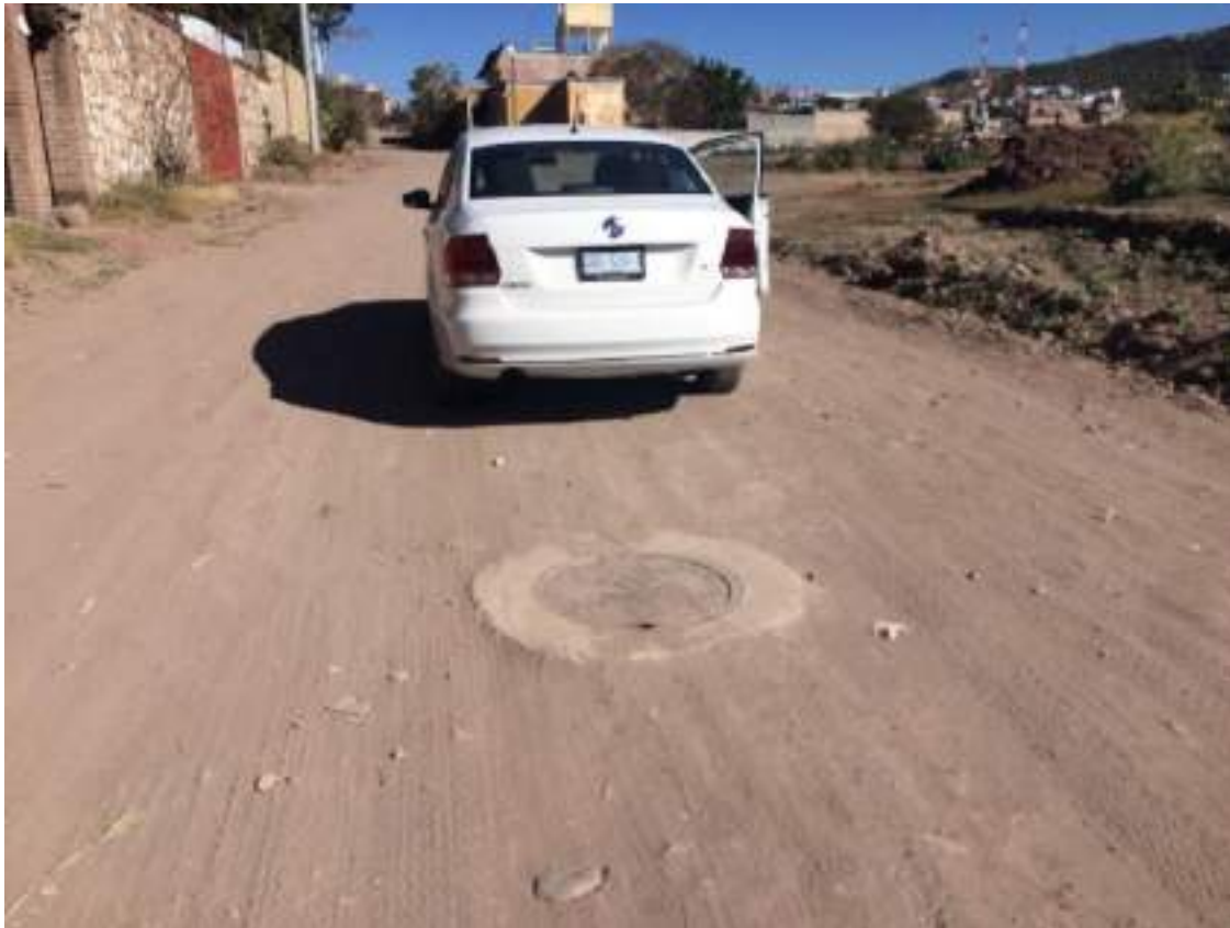
Obra terminada del colector sanitario Deportiva Yerbabuena.
