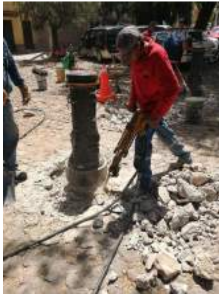
Paseo de la Presa-Retiro elementos vía pública Construcción de Parasol
