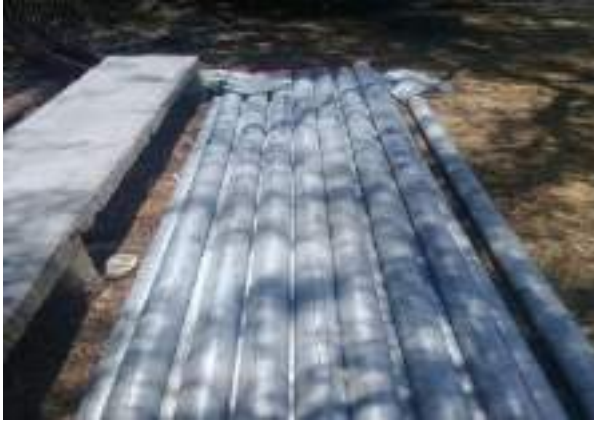
Construcción del equipo de bombeo, cloración y línea de conducción de agua potable en la Comunidad de Mexiamora, en el Municipio de Guanajuato. (Suministro de tubería).
