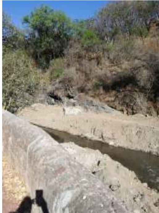
Encofrado de tuberías de polietileno con concreto ciclópeo armado con malla electro soldada.
