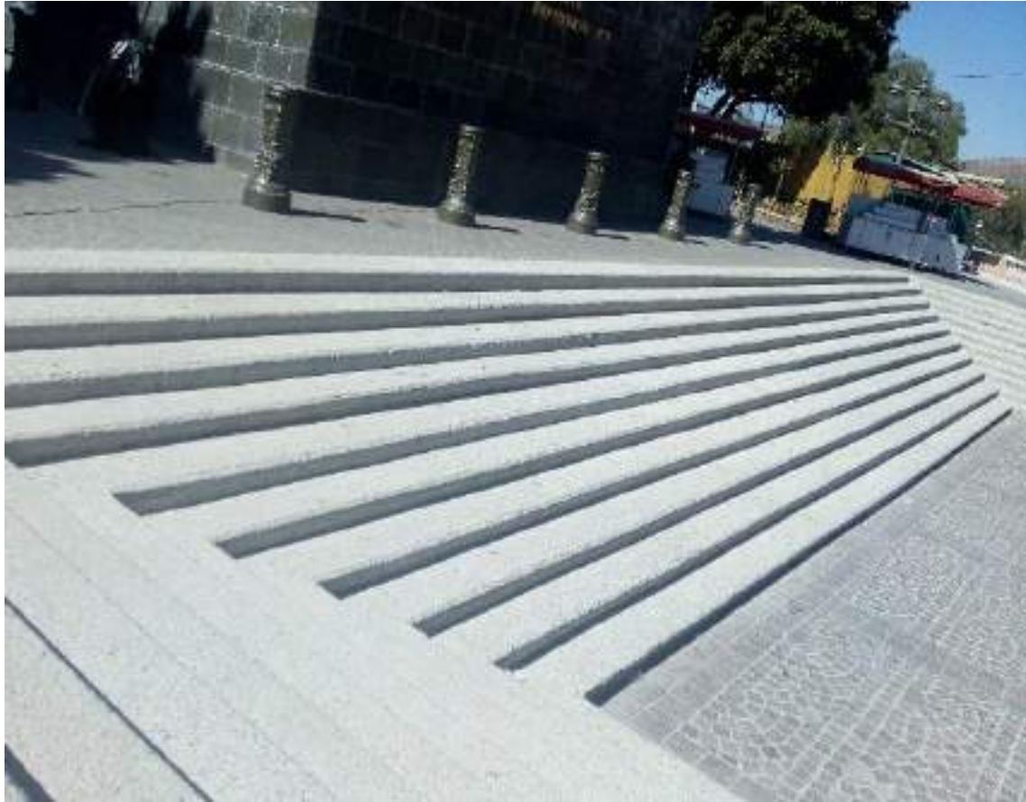
Restauración de gradas para auditorio al aire libre e iluminación en Plazoleta del Monumento al Pípila.
